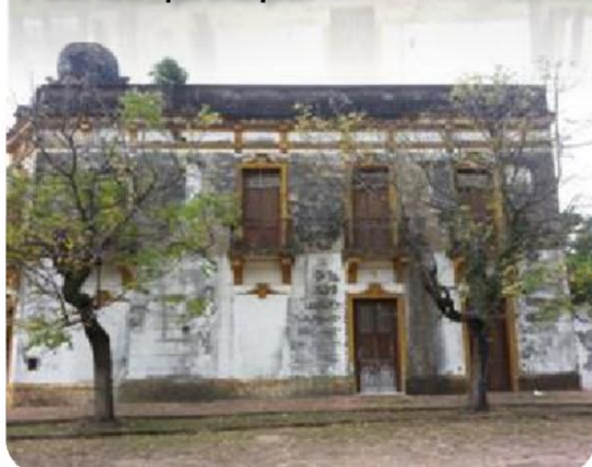
Fachada calle Mcal. Estigarribia
