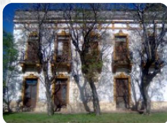
Fachada calle Colon
