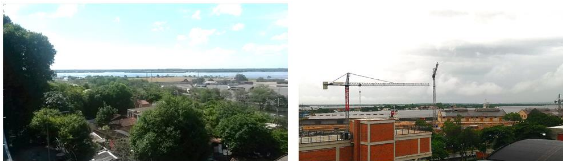
Ilustración 7 - Vista hacia el Rio Paraguay el proceso constructivo de las torres Ministeriales
