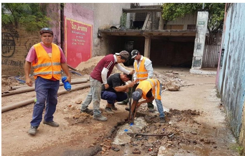
Ilustración 51 - El barrio durante de la intervención y colocación de los ductos subterráneos
