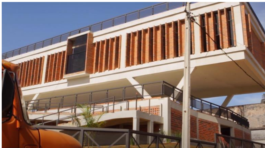
Ilustración 55 - Fachada principal del Centro Comunitario se destaca la estructura de hormigón armado a la vista,
