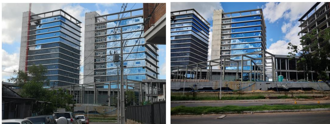
Ilustración 12 - Edificios Ministeriales en proceso de culminación
