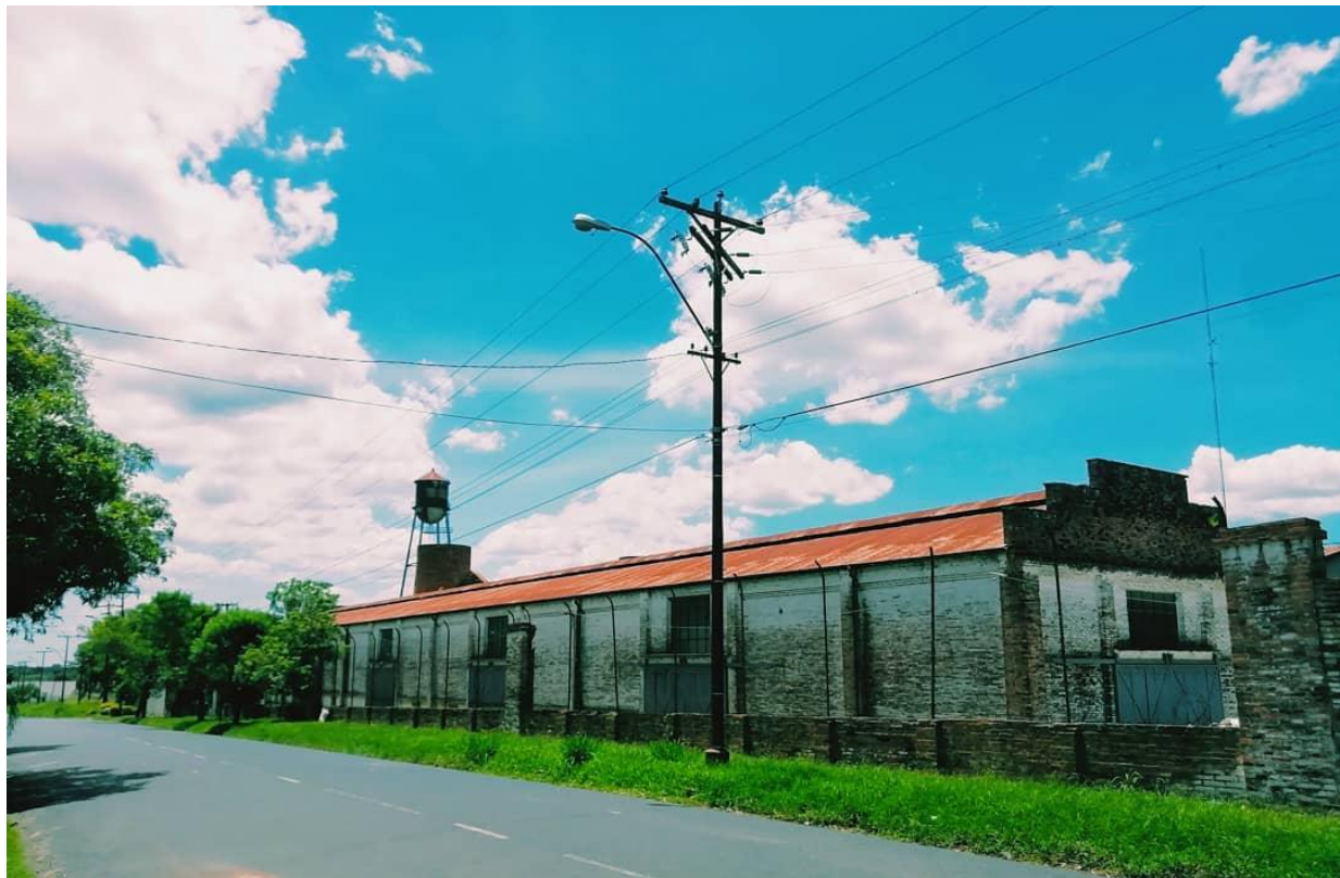
Figura 13. Construcción de la ex industria Anderson Clayton & Cia, situación actual.
