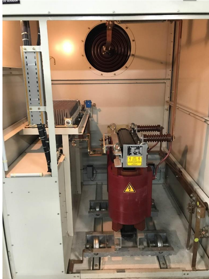
Figura 7.21: Aterrizaje del Generador con alta impedancia.
