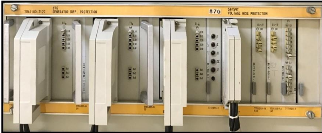
Figura 7.6: Modulo del relé 87G
