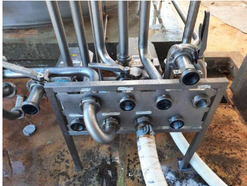
Figura B.1 Panel de tuberías
