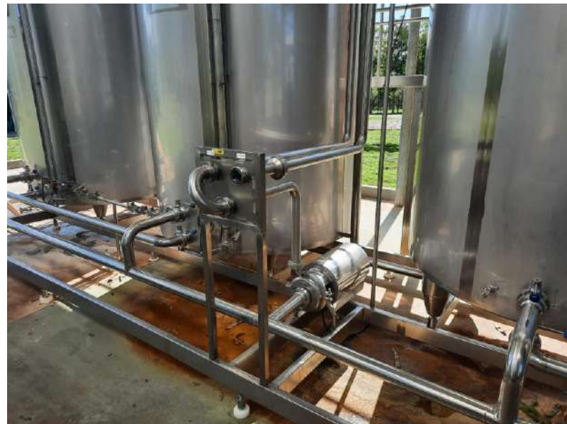
Figura B.2 Panel divisor de tuberías CIP
