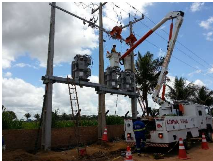
Figura 8.13.2: Montaje del compensador dinámico de 300 kVar/fase
