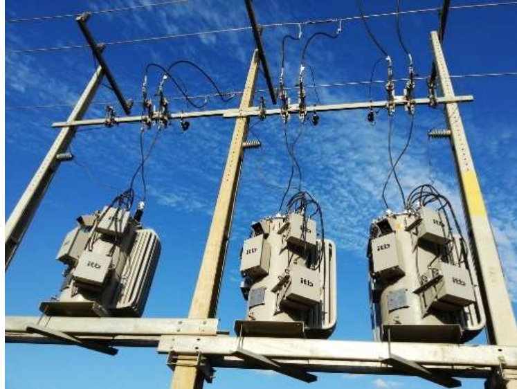
Figura 8.13.1: Compensador dinámico de 300 kVar/fase
