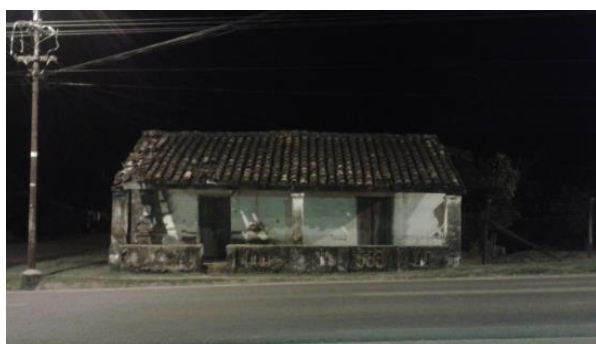
Ilustración 2 - Vivienda antigua, hasta el año 2018 (No catalogada) Fotografía: Arq. Jorge Landó.
