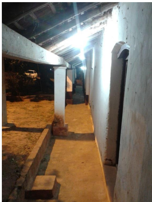
Ilustración 4 - Tira de viviendas al lado Este de la plaza principal. Fotografía: Arq. Jorge Landó
