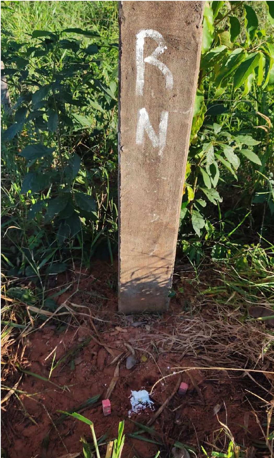
Colocación de RN1 en la Progresiva (0 + 050).
