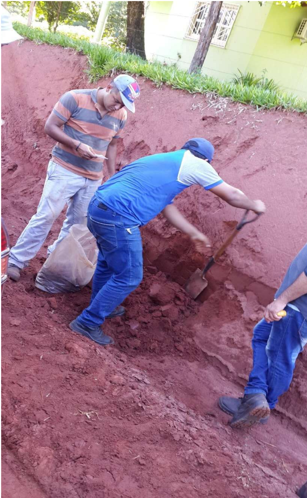
Extracción de muestras de suelo del tramo del proyecto.
