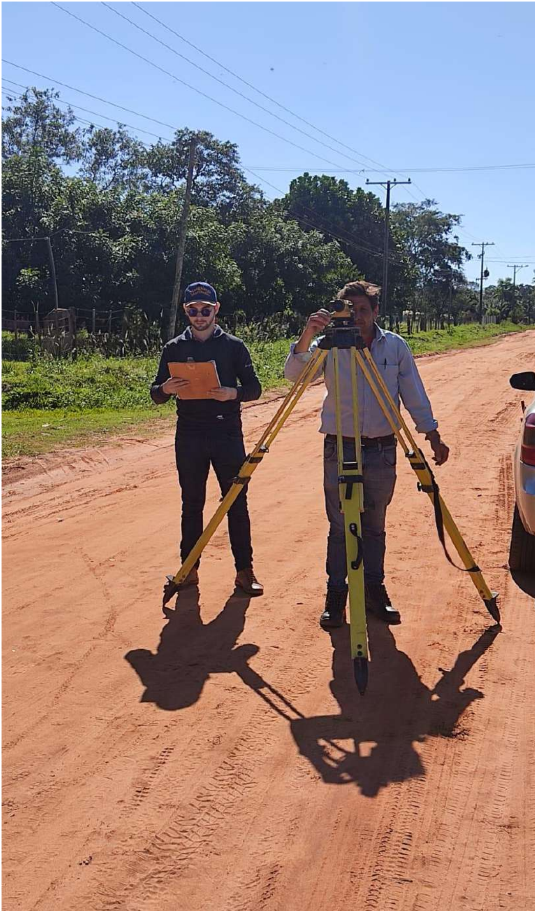
Inicio de la medición de los niveles del terreno con Teodolito.
