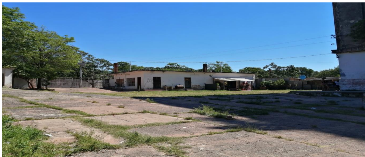
Imagen 17. Capasa, con ocupantes ilegales que fueron tomando el predio
