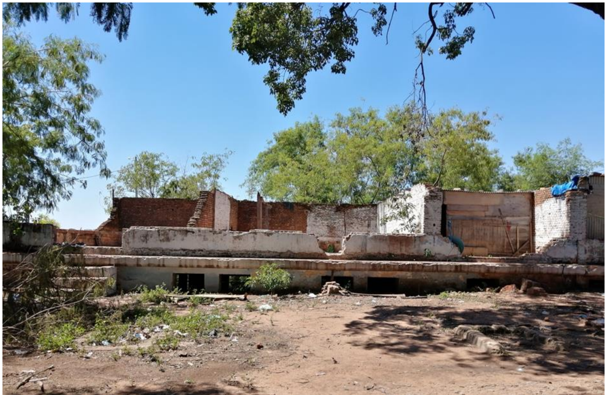
Imagen 15. Capasa, con ocupantes ilegales que fueron tomando el predio
