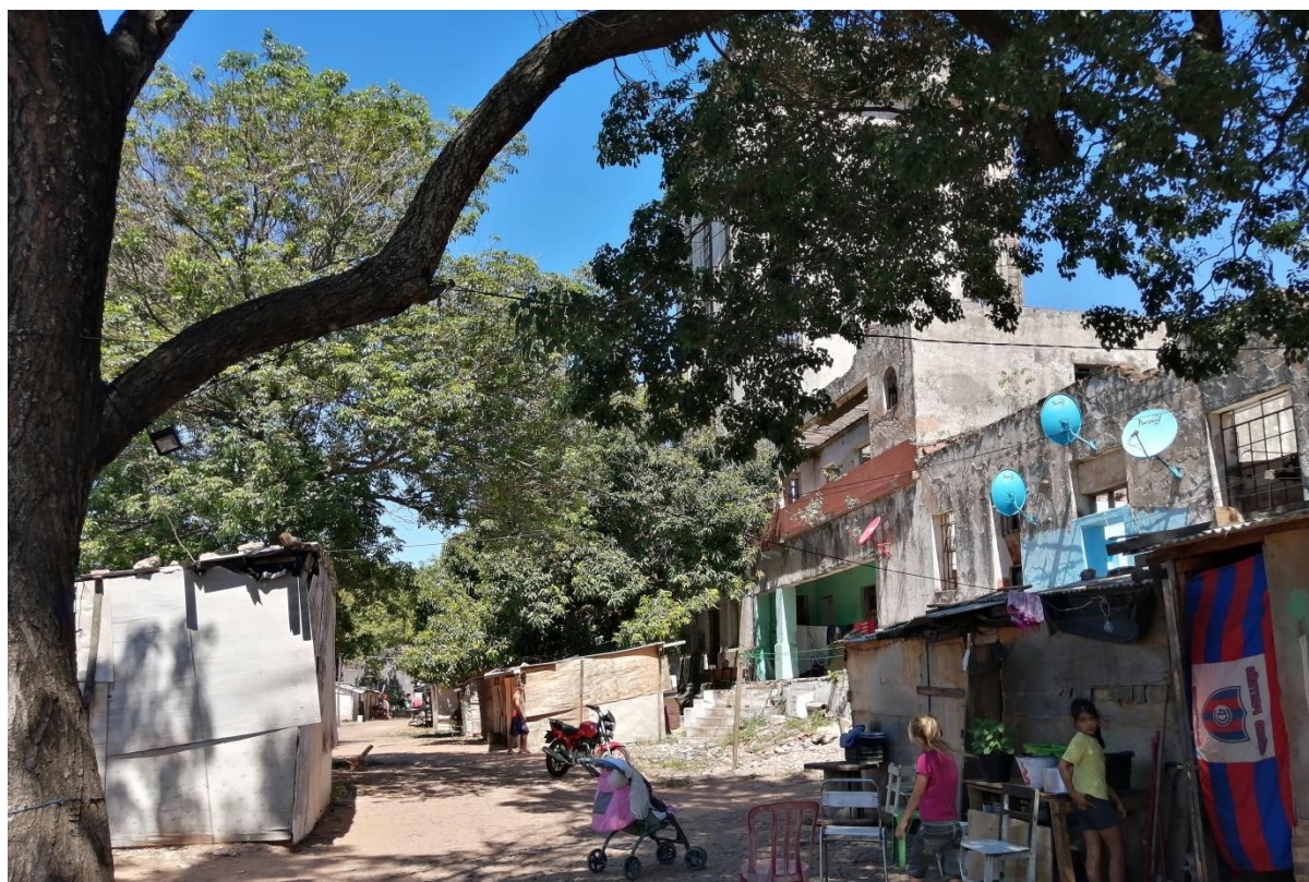
Imagen 16. Capasa, con ocupantes ilegales que fueron tomando el predio
