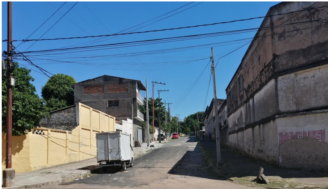
Imagen 24. Capasa donde no están los ocupantes.
