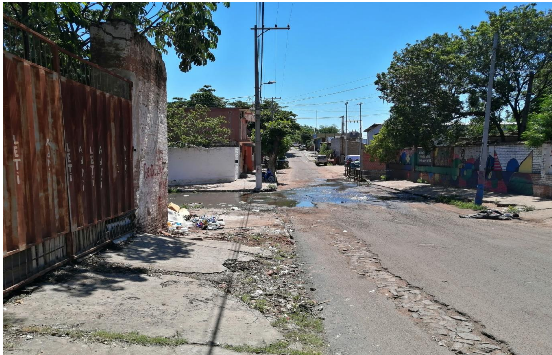
Imagen 25. Capasa donde no están los ocupantes.
