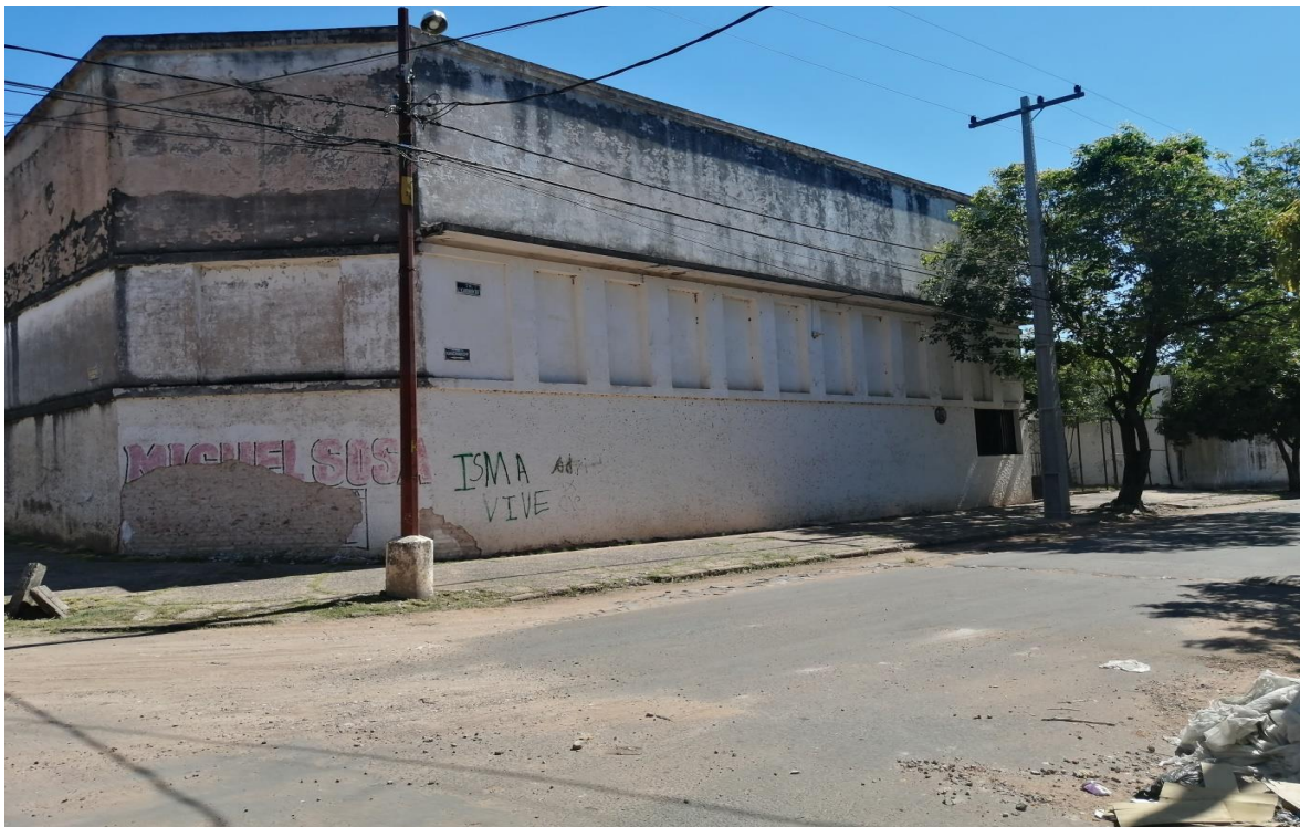
Imagen 23. Capasa donde no están los ocupantes.
