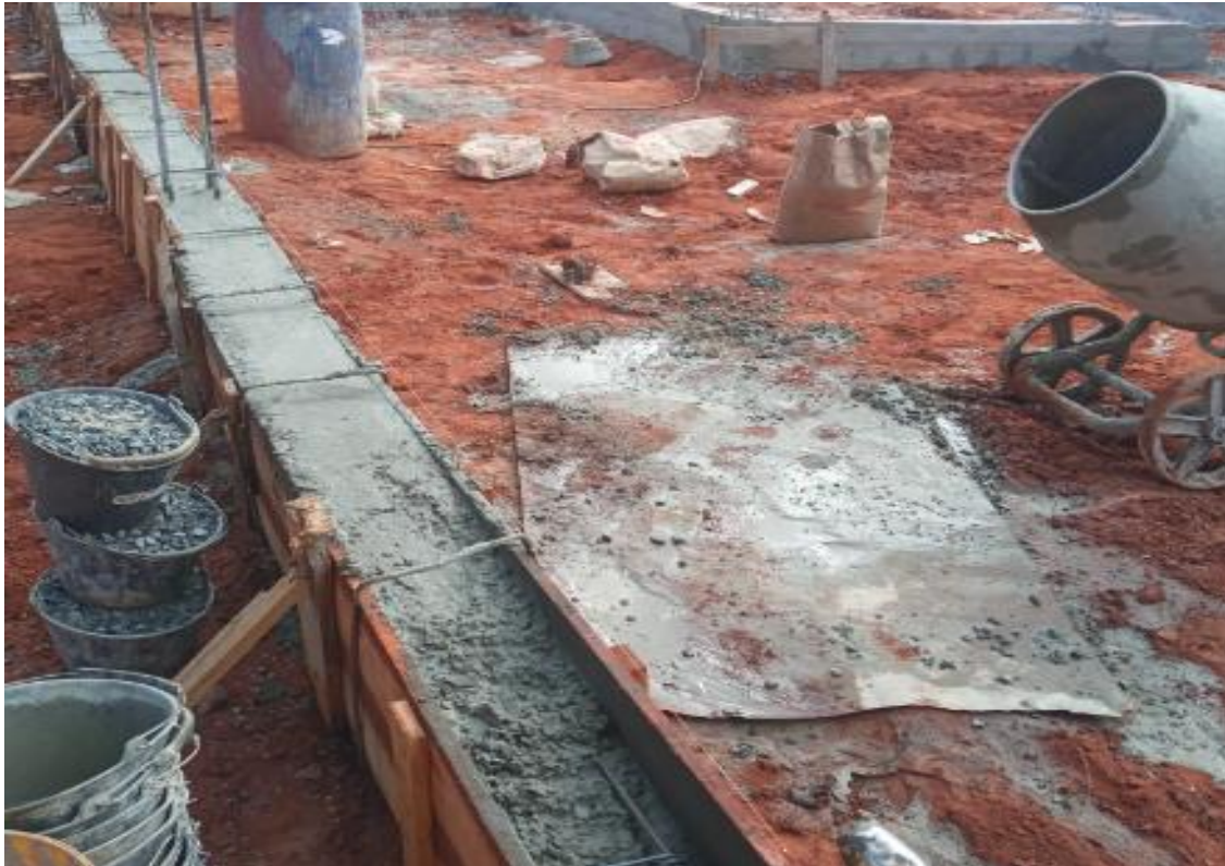
O20: Viga de Fundación.
