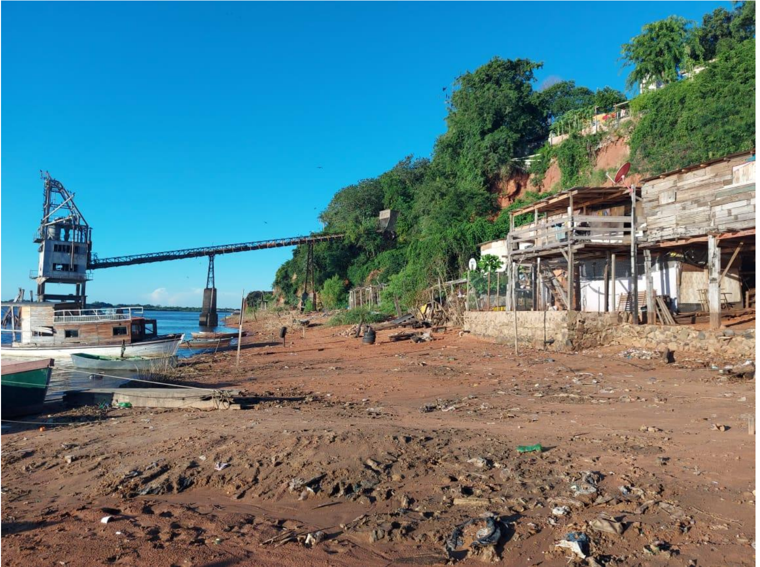
Anexo 16. Fotografía de la zona de estudio: Vivienda de Rodney Agüero en la zona baja del barranco de Molinos Harineros
