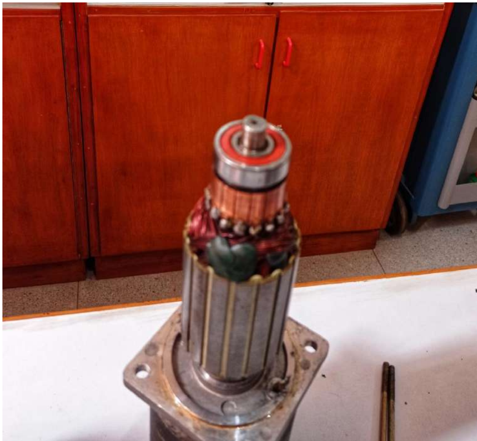
Figura 48. Mantenimiento al motor eléctrico.
