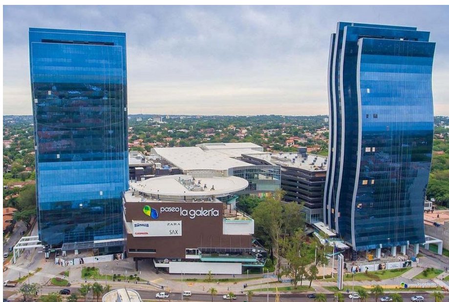
GRÁFICO 27. Fotografía Edificio Blue Tower junto al paseo la Galería Asunción. Edificio completamente vidriado.
