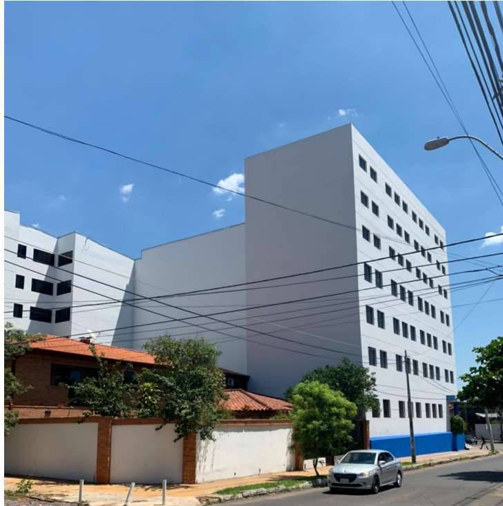
GRÁFICO 46. Fotografía Vista Posterior. Este y Norte del edificio de Post Grado.
