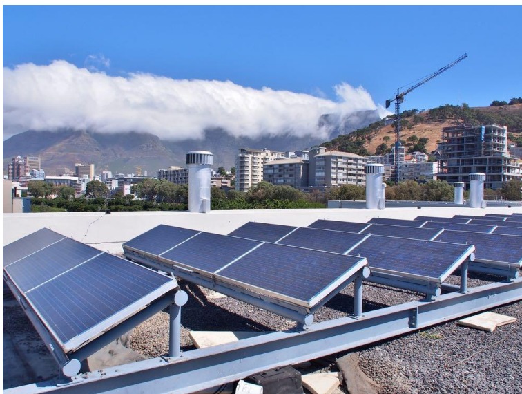
GRÁFICO 69. Montaje de paneles solares en techos de edificios
