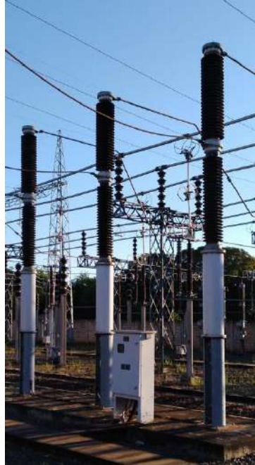
Figura 5: Interruptor de potencia monopolar del tipo SB6.
