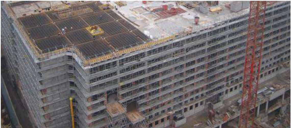
Figura 4. 4 – Etapa de Construcción del Hospital Borgo Trento.
