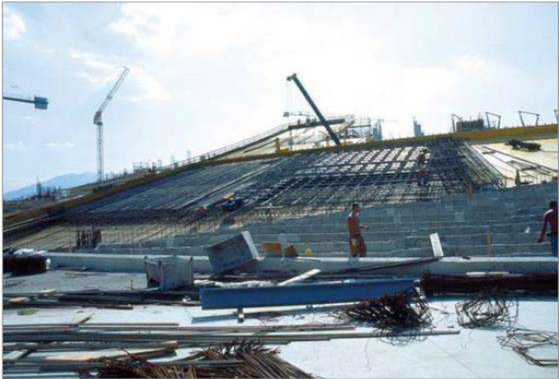
Figura 4. 2 – Etapa de Construcción del Vulcano Buono Shopping Center.
